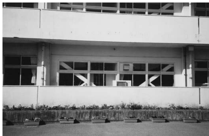
耐震補強工事完了で安全な校舎
