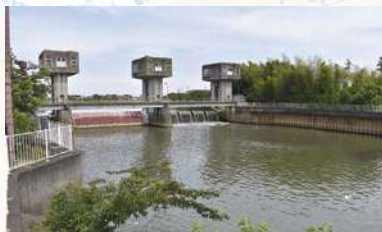
▲現在の古利根堰で、昭和61年(1986)に新たに造成。大正10年の堰よりも少し上流部分に移設。
