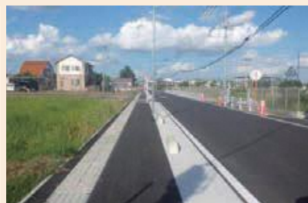
歩道が整備された町道3号線
