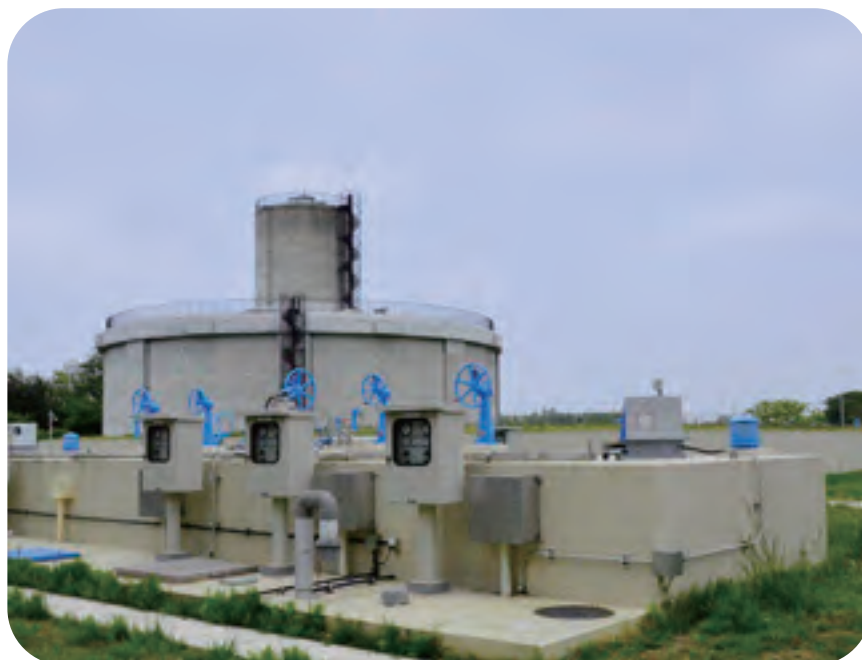
築比地浄水場の貯水タンク(配水池)
